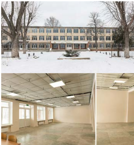
Фото: Русько-Лозівський ліцей. Джерело: Презентаційні матеріали «ВІДБУДОВА МІСЦЕВИХ ШКІЛ ЗАДЛЯ СТІЙКОСТІ». https://shorturl.at/X7J1 . Використано в освітніх цілях.
